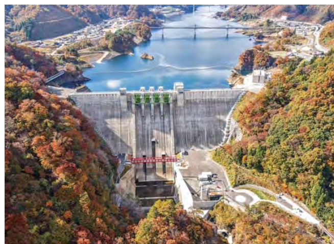
八ツ場ダム 写真提供: 利根川ダム統管理事務所
